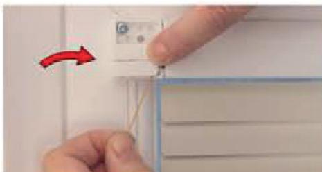
13. Presser la patte de verrouillage sur la corde pour sécuriser l'ensemble. Vérifier que le produit tient dans toutes les positions
