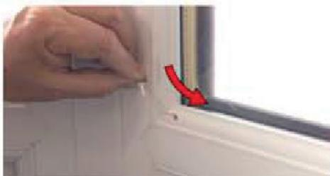
10. Pousser le cordon dans le trou, poussez l'œillet de fixation dans le trou, en l'alignant dans la rainure
