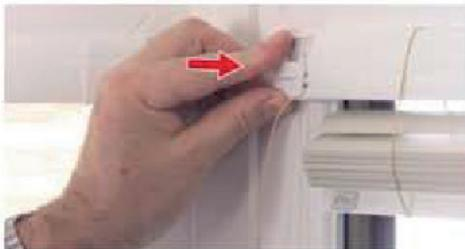
7. Coller le store sur le cadre de la fenêtre en laissant le joint autour apparent
