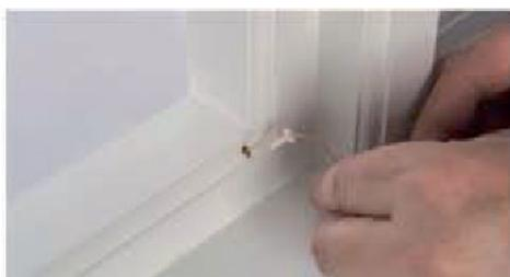
a4. Poussez le cordon dans l'insert en laiton, poussez l'oeillet dans l'insert en laiton, en alignant à la rainure
